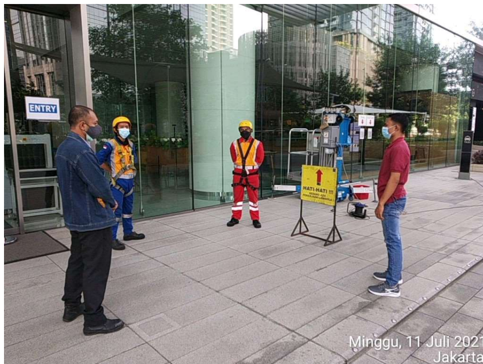
Photo 13. Setiap Sebelum Mulai Bekerja Pengawas & Pekerja Personal Basket atau Manlift Melakukan Safety Briefing Ingatkan Prosedur Keselamatan Kerja.
