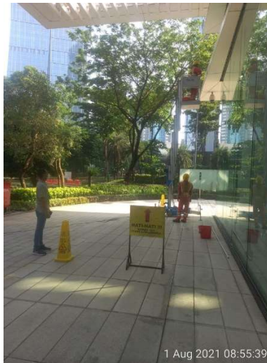
Photo 15. Prosedur Yang Wajib Dilakukan Isolasi Area & Tempatkan Rambu Waspada Jaga Jarak Aman Dengan Alat Manlift Yang Sedang Ereksi Dipakai. Procedure Shall To Be Done To Isolate Area & Placed A Warn Sign to Keep Safe Distance toward Manlift is on Erection in Working
