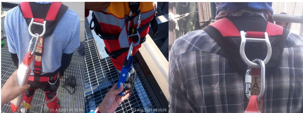
Photo 26. Cincin D Adalah Lubang Cincin yang Ada Pada Sabuk Keselamatan yang Lubangnya Di Depan & Di Belakang Wajib Dimasukkan Karabiner Yang Keras & Ikatan Dikunci Jika Ingin Selamat Selama Bekerja untuk Keselamatan Pekerja Tersebut. D Ring is A Ring Hole in The Safety Harness That Front Hole & Back Hole That Shall Be Entered by Hard Carabiner & Lock The Bond For Safety During Working at Height.
